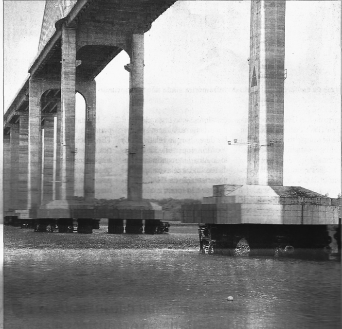
Cabotagem depende de novos estudos sobre o calado do porto e de defensas nas pilastras da ponte
